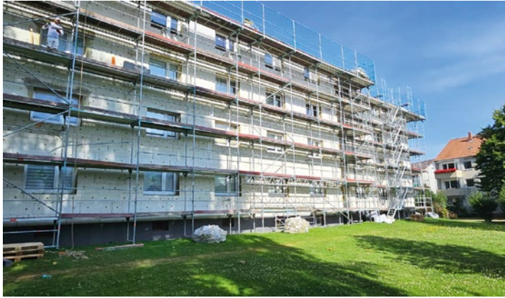
Das aktuelle Objekt vom HM Ideenhaus, zur Sanierung gehört auch die Fassadendämmung.
